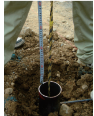
落下高さ確認
